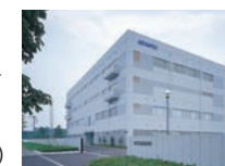
● 東洋濾紙 (株) 芳賀工場
